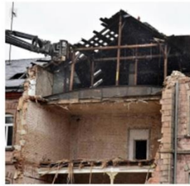
Während im Hintergrund immer noch verzweifelt versucht wird, den Teilabriss des Ostflügels der ehemaligen HuPfla zu verhindern, schaffen die Abrissbagger Fakten. (Foto: Harald Hofmann)
