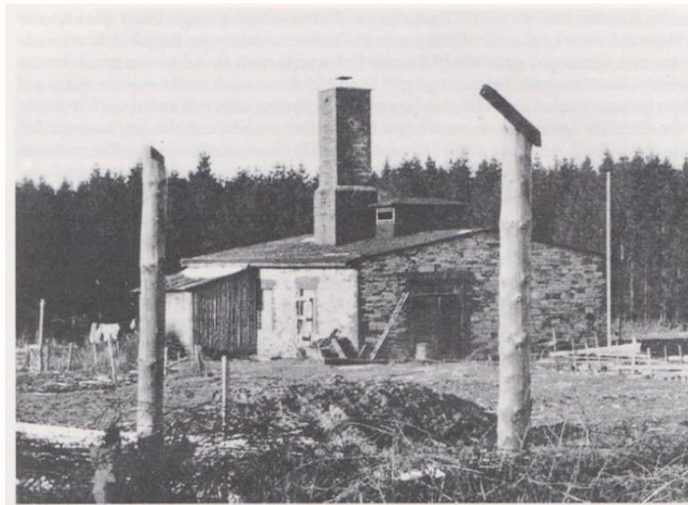
„1942 wurde ein Krematorium im KZ Niederhagen errichtet. Nach dem Krieg wurde es von Flüchtlingen bewohnt, ca. 1947 – 1950“ 118
