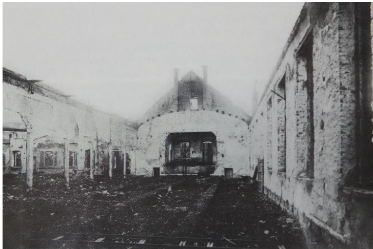
„Die Schützenhalle im Jahre 1945. Das Bild zeigt den Kleinen Saal, an dem rechts deutlich noch die Sperrgitter in den Fenstern zu sehen sind.“ 17
